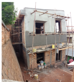
L'ESC pendant sa construction
