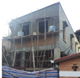
En cours de réalisation fin septembre 2022
